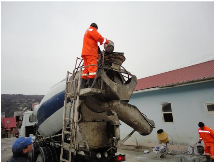
Рисунок 3. Введение раствора добавки в миксер
