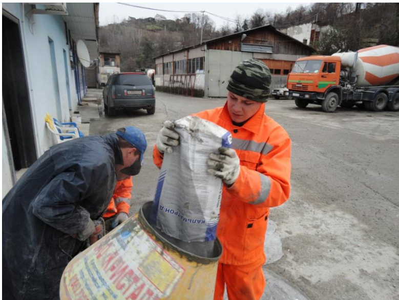
Рисунок 2. Засыпка добавки в бетономешалку
